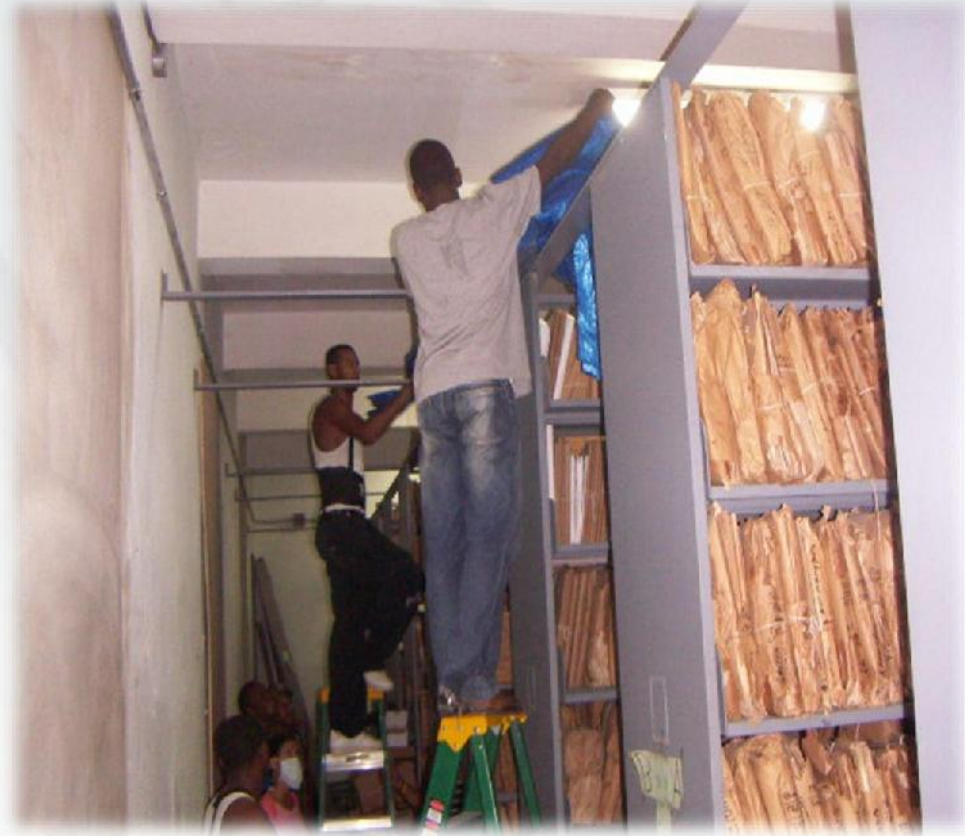
Revestimiento con lonas
