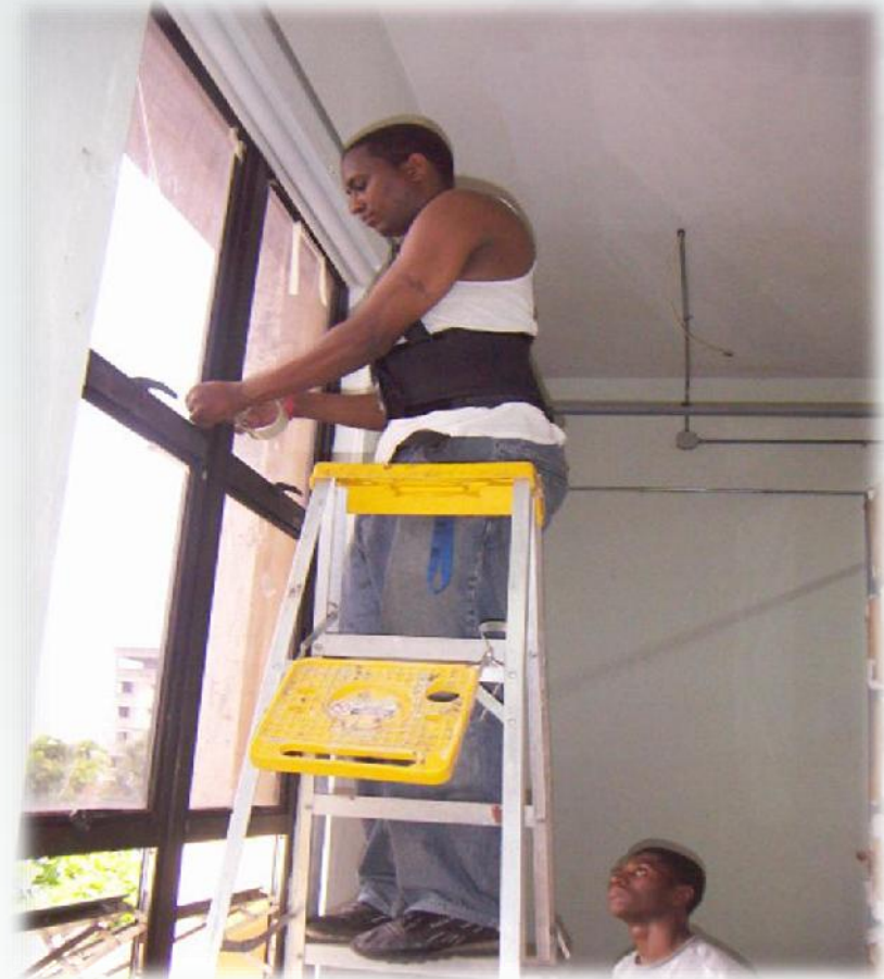
Sellado de ventanas
